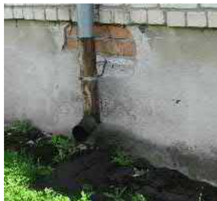
4.1.4.att. Cokols ar melniem un za iem, mitruma plankumiem, nodrupis apmetums.
