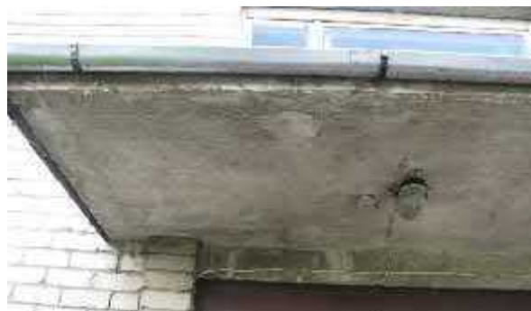
4.9.9.att. Jumti š ar mitruma plankumiem un apdares nodrupumiem.
