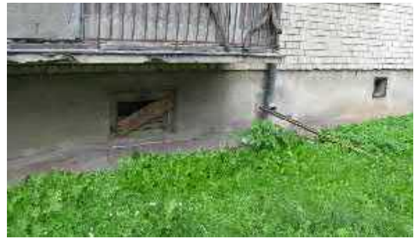
4.1.6.att. Cokolam pieguloš s zemes teritorijas l menis ir augst ks par apmali.
