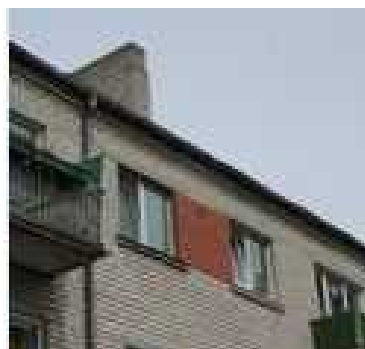
4.16.2.att. Ventil cijas kan li virs jumta.
