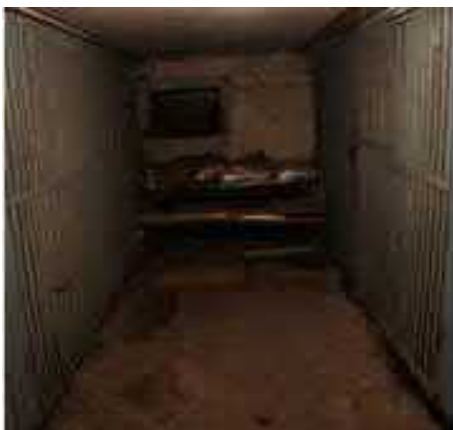
4.1.1.att. Pagrabst v pie š n šiem gaiten uz gr das mitruma plankumi.
