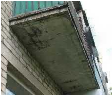
4.9.3.att. Balkons nesoš pl tne ar betona aizsargk rtas izdrupumiem.
