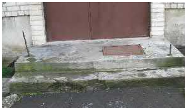
4.9.8.att. Ieejas lievenis monol t betona, pak pieni ar met la malu.
