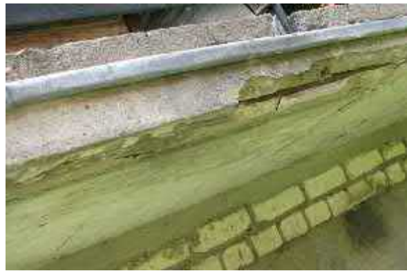
4.9.4.att. Balkons nesoš pl tne ar betona aizsargk rtas izdrupumiem.
