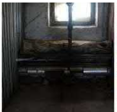
5.10.1.att. Siltumtrases izol cija apmierinoš st vokl .
