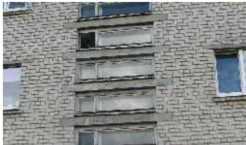
4.3.1.att. P rsedz m nelieli apdares un betona virsmas izdrupumi.
