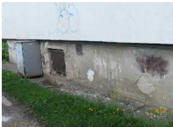
4.1.3.att. Apmale deform jusies, ar izdrupumiem, aizaugusi ar z li.
