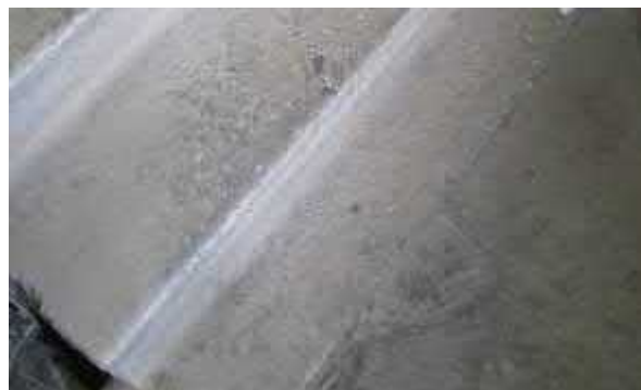
4.10.2.att. Pak pienu un k p u laukums ar virsmas izdrupumiem.
