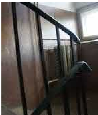
4.10.3.att. K p u margas met la konstrukcijas ar plastik ta lenteri.
