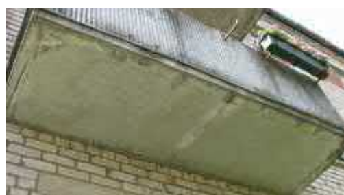
4.9.2.att. Balkonam otr st va l men pl tnes mala ar betona izdrupumiem.
