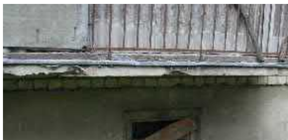
4.9.1.att. Balkonam pirm st va l men pl tnes mala ar betona izdrupumiem.
